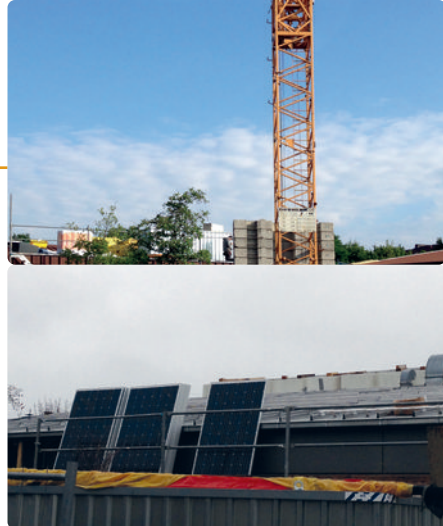
Dachrenovierung und Solaranlage
